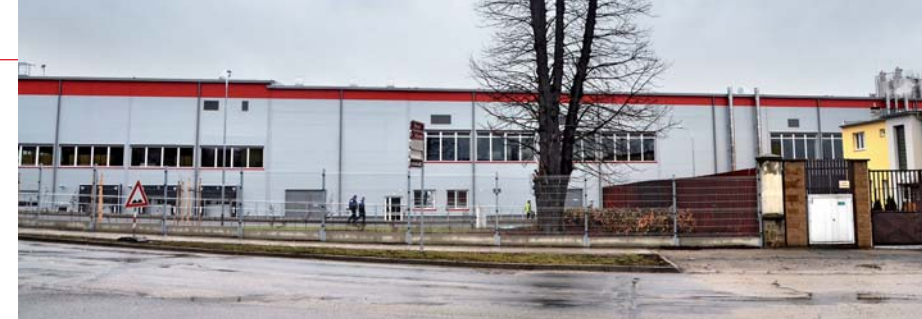
Částečný pohled na rosickou pekárnu
